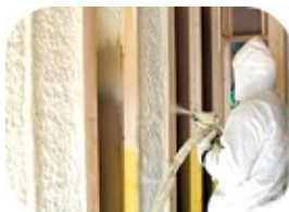
発泡吹き付け断熱材
